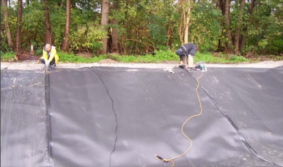
Schweißen und Prüfung der Foliendichtung
